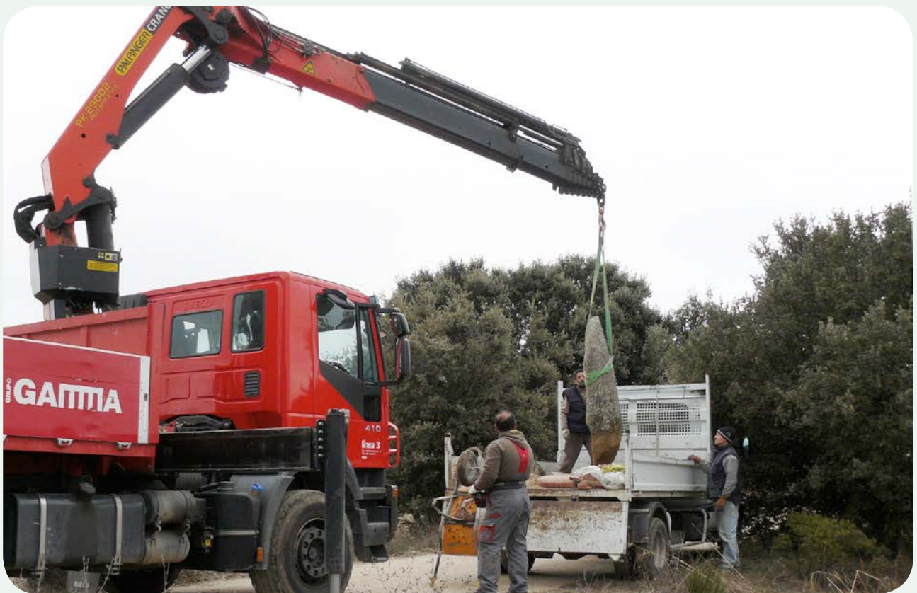
RECUPERACIÓN, TRASLADO E INSTALACIÓN EN LA CALZADA (3). Descargando la pieza en el margen derecho de la calzada, para instalarla en el hueco practicado en el terreno previamente.
