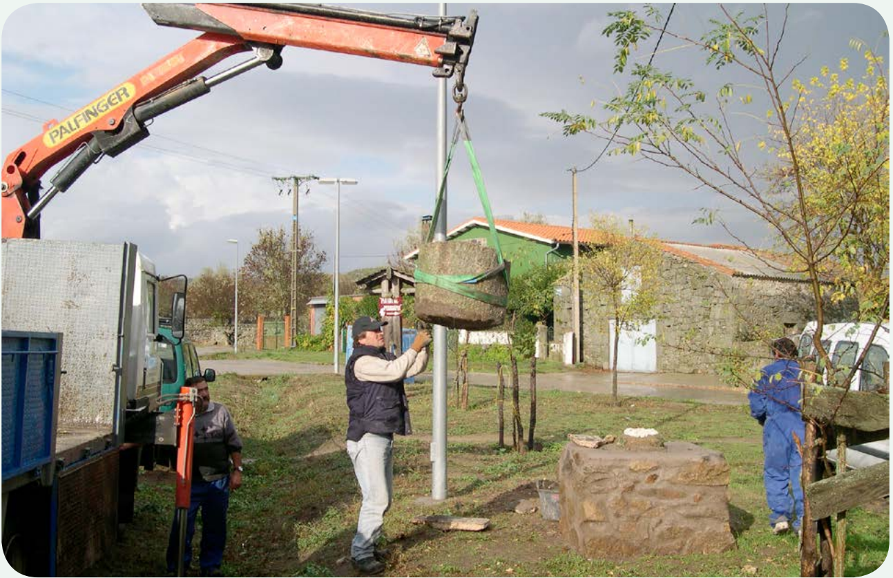
RECUPERACIÓN, TRASLADO E INSTALACIÓN EN LA CALZADA (2). Descarga de la pieza para colocarla en el pedestal realizado al efecto previamente en la zona ajardinada situada a la salida de la población, junto a la carretera que se dirige a Valdelacasa.
