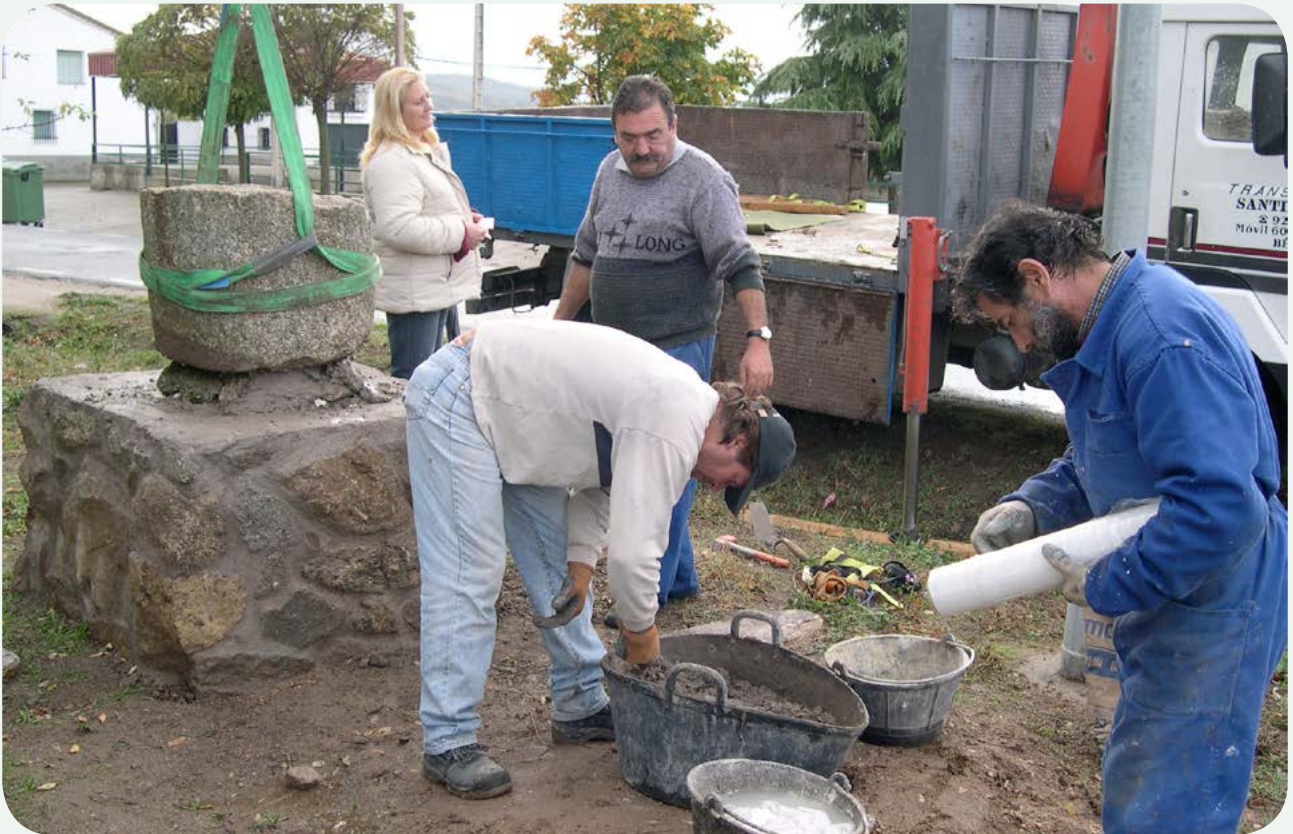
RECUPERACIÓN, TRASLADO E INSTALACIÓN EN LA CALZADA (3). El fragmento colocado sobre el pedestal, antes de protegerlo con plástico para evitar el contacto con el cemento.
