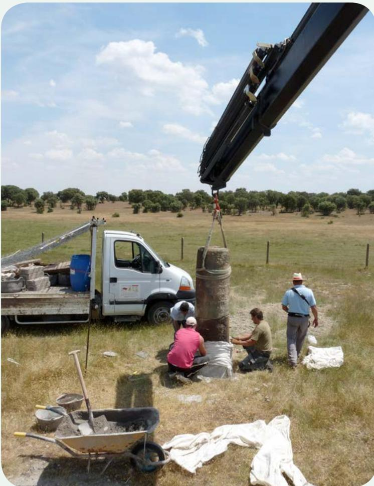
**TRASLADO E INSTALACIÓN EN LA CALZADA (3)** Aplomando el miliario y protegiendo la base con malla geotextil, para evitar el contacto del granito de la columna con el cemento.
