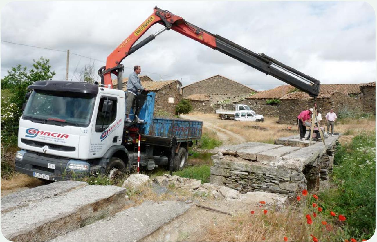
**DESMONTE DEL PUENTE Y RECUPERACIÓN (1).** Inicio del proceso de desmonte del puente para recuperar los miliarios, con la retirada de las grandes lajas del pavimento, mediante la ayuda de un camión dotado de grúa pluma.
