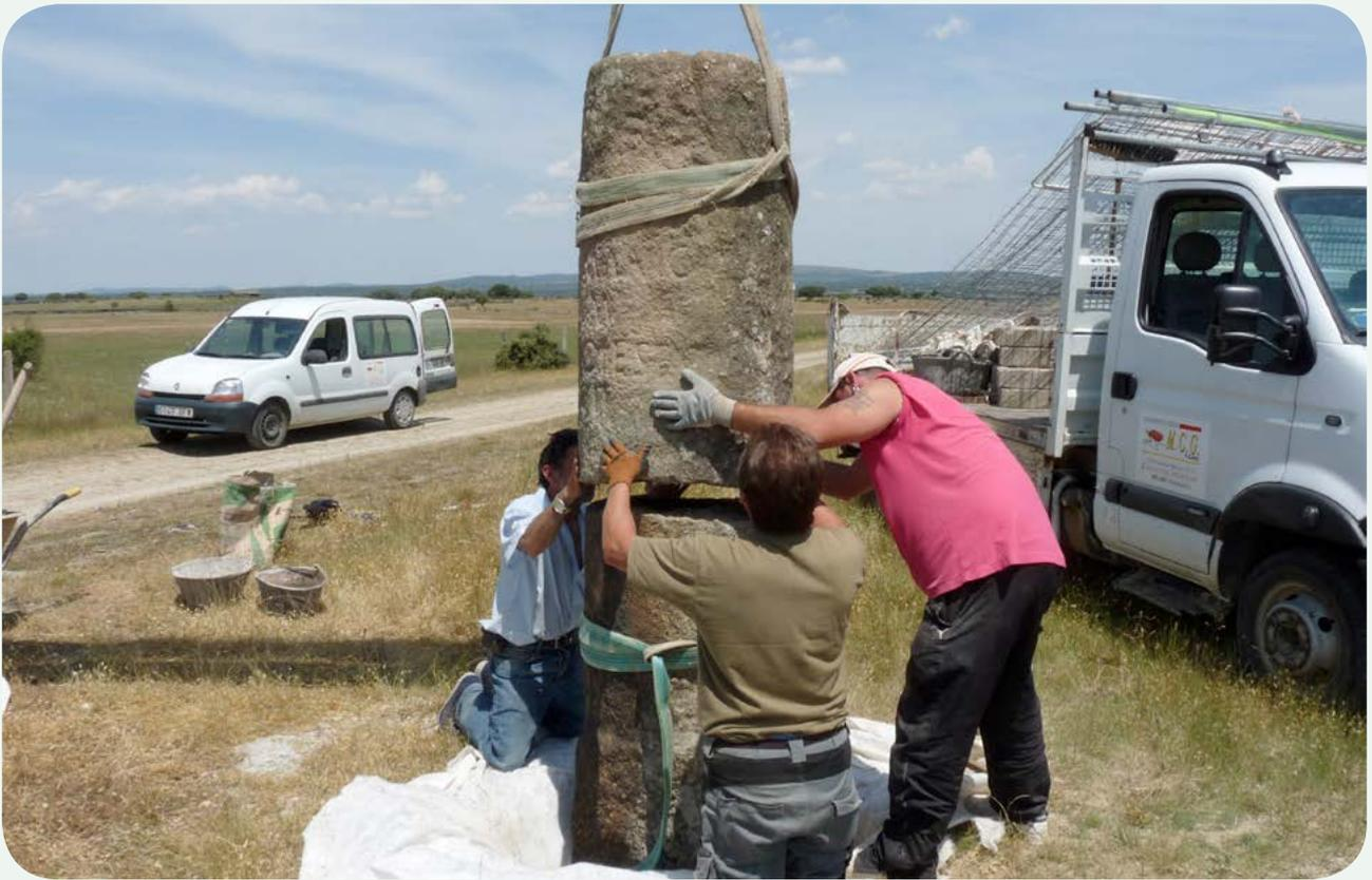
**TRASLADO E INSTALACIÓN EN LA CALZADA (2).** Ensamblando los dos fragmentos, una vez introducido en el hueco en el terreno realizado previamente.
