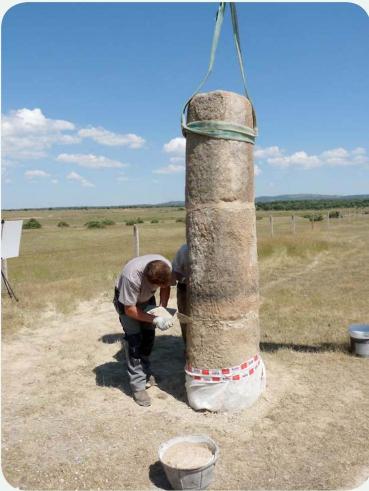
TRASLADO E INSTALACIÓN EN LA CALZADA (5). Rellenando las juntas entre fragmentos, una vez instalado.
