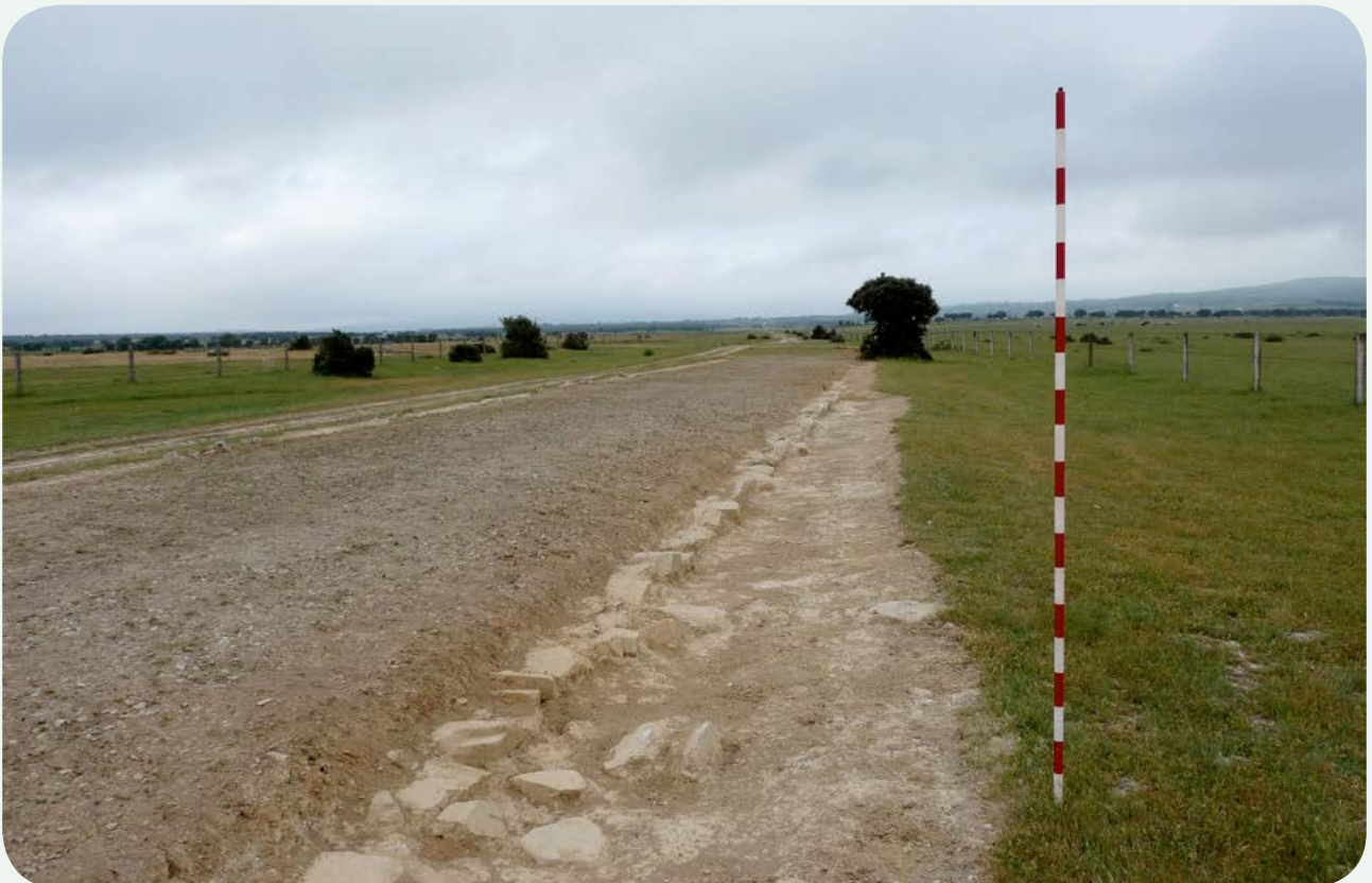
VISTA GENERAL DEL TRAMO DE CALZADA (2). Otra vista del mismo tramo, poco antes de instalar el miliario en la milla 154, unos metros antes el carrasco que se observa al fondo.
