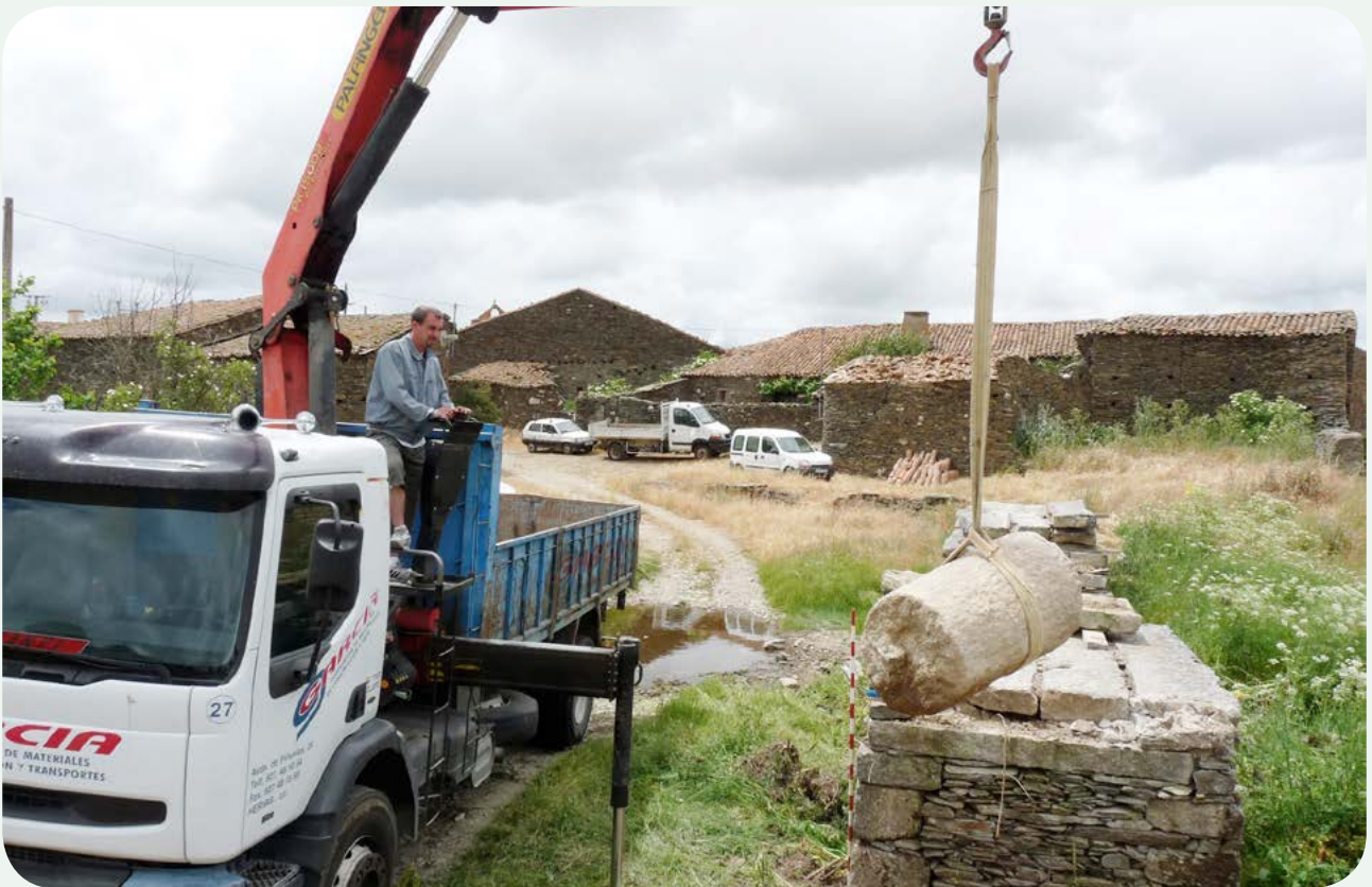
DESMONTE DEL PUENTE Y RECUPERACIÓN (2). Izado del fragmento central, para almacenarlo temporalmente en las inmediaciones del puente, hasta el traslado a la calzada.
