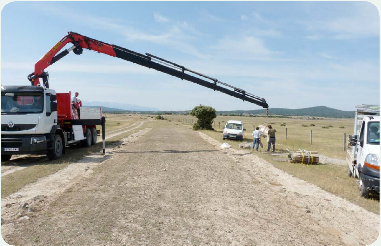
TRASLADO E INSTALACIÓN EN LA CALZADA (1). 24 de junio de 2010. Descargando los tres fragmentos del miliario.
