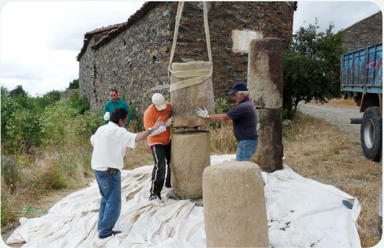
DESMONTE DEL PUENTE Y RECUPERACIÓN (3). Haciendo las comprobaciones necesarias para ver si los tres fragmentos pertenecían a un mismo miliario, como así sería finalmente.
