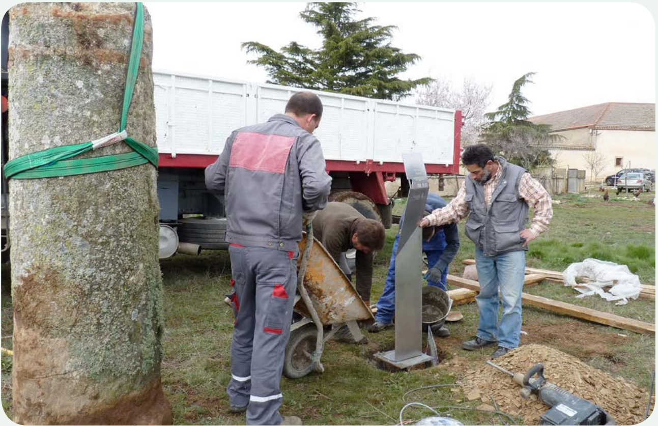
TRASLADO E INSTALACIÓN EN LA CALZADA (6). Colocación junto al miliario de una señal de Tipo 3 ITER PLATA, en la que consta la información relativa a la epigrafía de la columna y la milla correspondiente de la Vía de la Plata.
