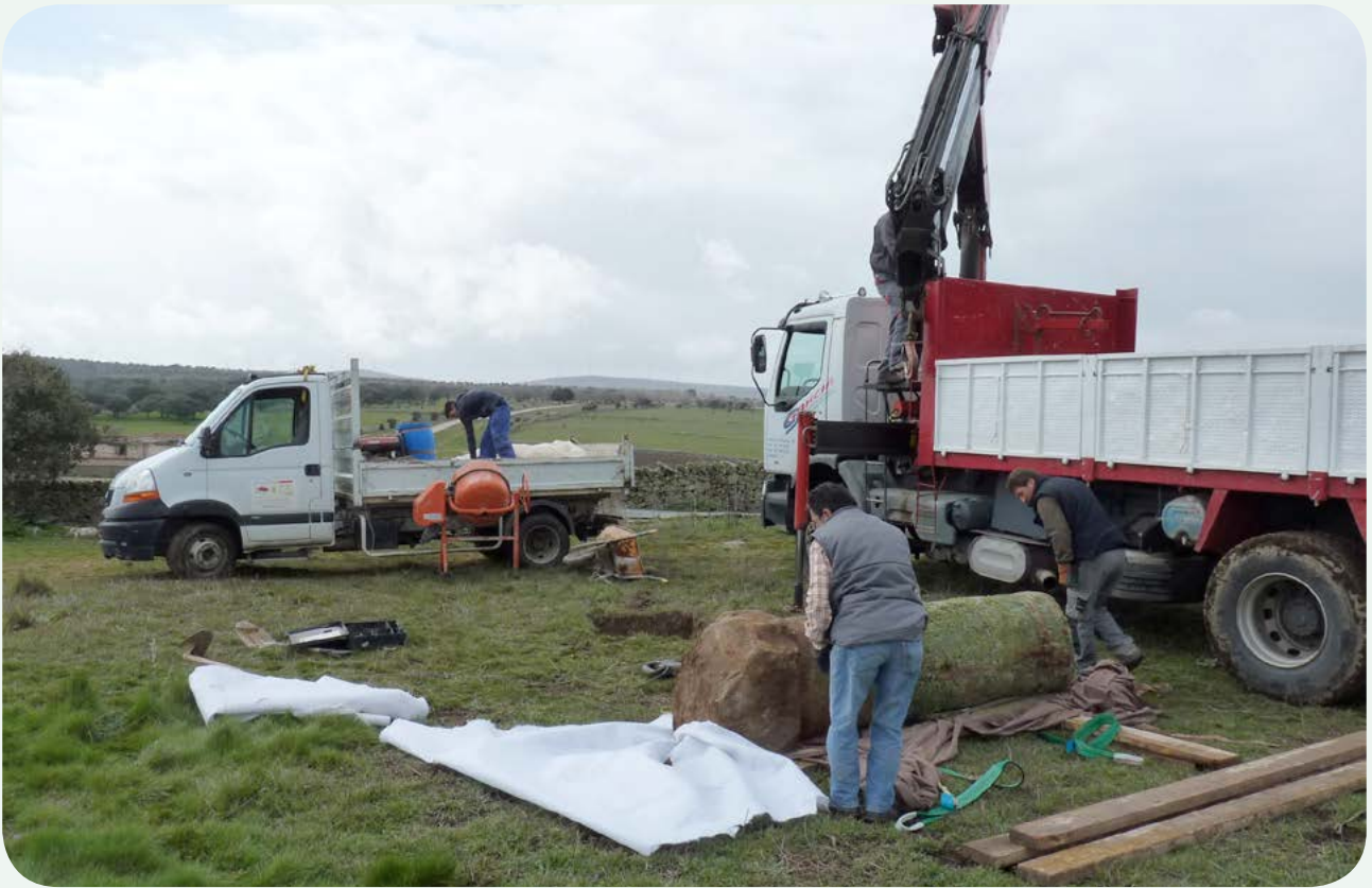
TRASLADO E INSTALACIÓN EN LA CALZADA (4). El miliario una vez descargado en el lugar de reposición, junto al hueco practicado con anterioridad en el terreno, para insertarlo dentro del mismo. Previamente se protege la base con malla geotextil, para evitar el contacto del cemento con el granito.
