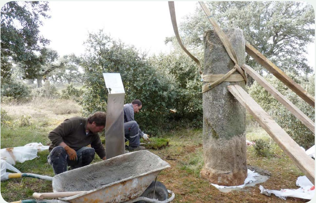
**RECUPERACIÓN, TRASLADO E INSTALACIÓN EN LA CALZADA (6).** Colocación de la señal de Tipo 3 ITER PLATA junto al miliario, una vez protegida la base con malla geotextil y asentado, aplomado y rellenado de cemento el hueco.
