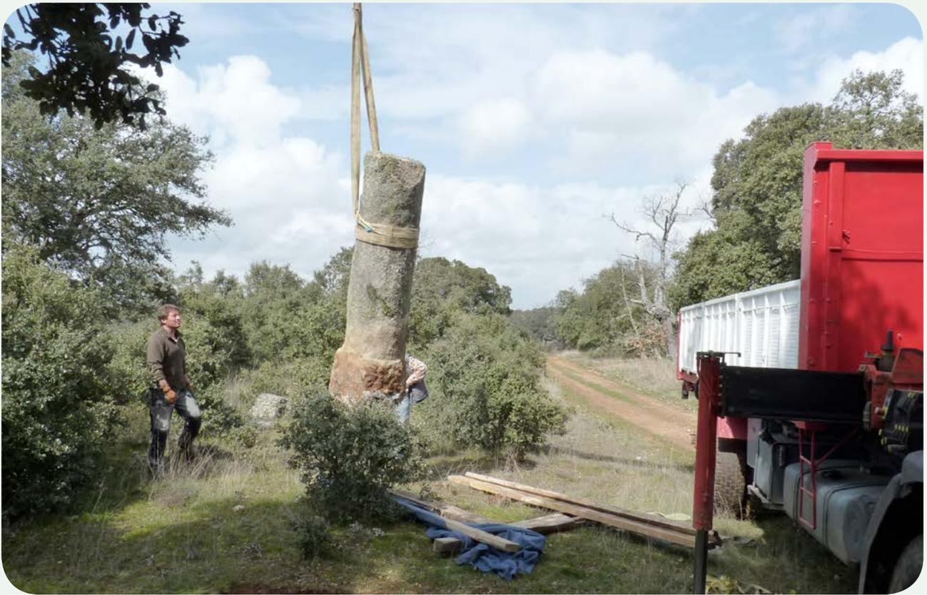
**RECUPERACIÓN, TRASLADO E INSTALACIÓN EN LA CALZADA (5).** Descargando la columna en la milla 165, para su colocación en la anterior base de cemento, en primer plano de la fotografía.
