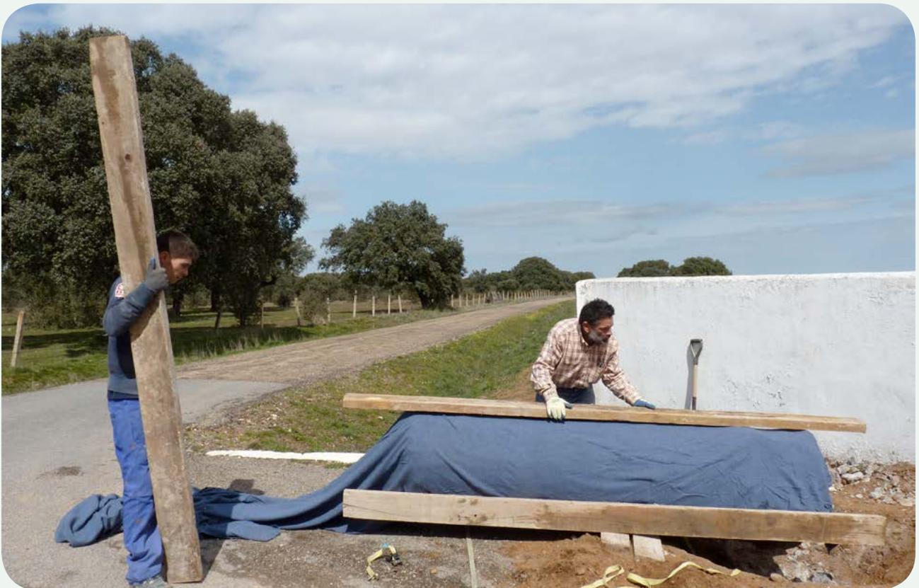
**RECUPERACIÓN, TRASLADO E INSTALACIÓN EN LA CALZADA (2).** Una vez recuperado el miliario es envuelto en una manta fuerte y a continuación se le protege para el traslado, con una estructura rígida de tablones, fuertemente cinchados alrededor de la pieza.
