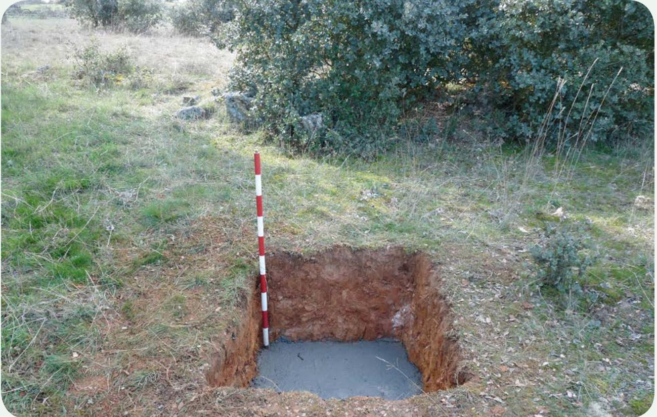
**RECUPERACIÓN, TRASLADO E INSTALACIÓN EN LA CALZADA (4).** Preparación para la instalación de la columna miliaria en la milla 165. El proceso, invariablemente, es el siguiente; en primer lugar se practica el hueco en el terreno, seguidamente se instala en el fondo un entramado de hierros entrelazados entre sí mediante alambres, y finalmente se deposita una capa de cemento, que sirve de asiento al miliario.
