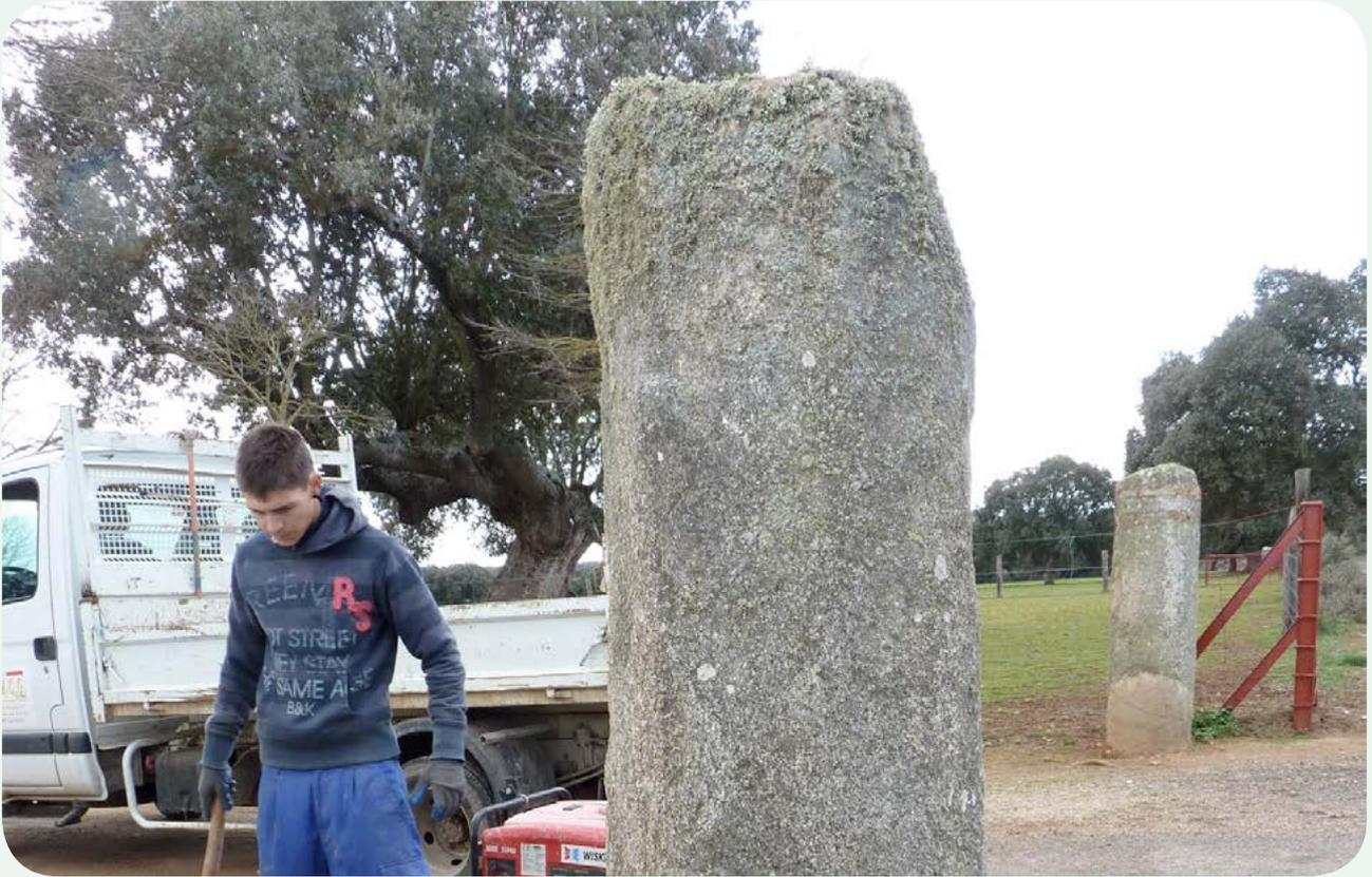
**RECUPERACIÓN, TRASPORTE E INSTALACIÓN EN LA CALZADA (1).** Proceso de retirada de la tierra y del cemento que lo anclaba al subsuelo. Fue necesaria la utilización de un compresor neumático para liberarlo.
