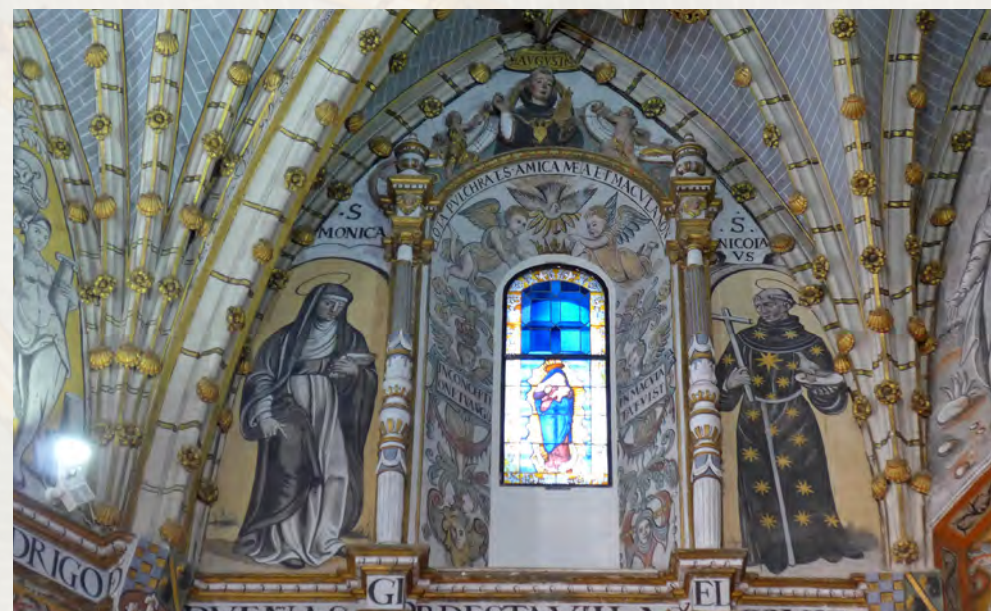
Grisallas y elementos arquitectónicos en el registro alto del lado sur del ábside
