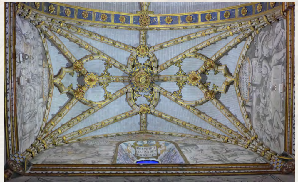
Bóveda del crucero norte
