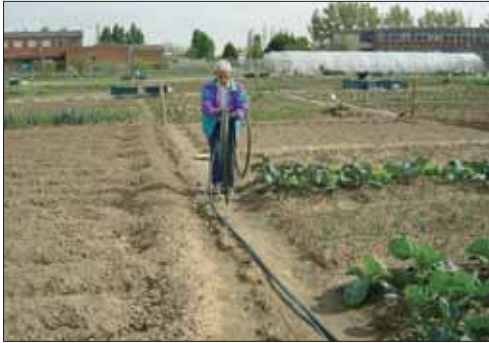
14.3: extensión de la tubería general
