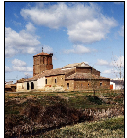
Foto 3: Iglesia de Santiago (Calzada de los Molinos).
