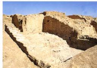
Vista parcial de la cimentación de la terraza artificial porticada, en su lado E.
