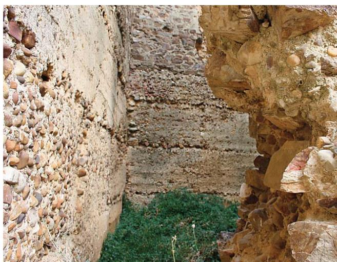
*Tapias de bormigón encofrado en hiladas sucesivas, agujas y sillería posterior en el castillo. A. Balado, 2010.*
