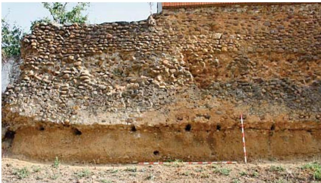
*Muro de encofrado sobre tapia de tierra anterior con mechinales para arriostrar el muro. Tramo suroeste. A. Balado, 2010.*
