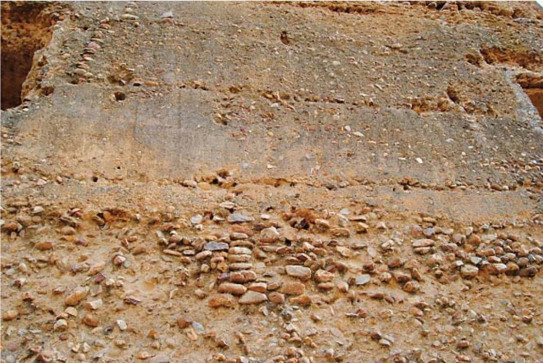
*Detalle de tapia encofrada. E. L. Corraliza..*
