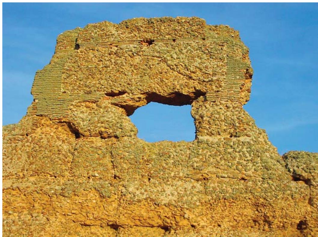
*Materiales de construcción cal, canto y machones y verdugadas de ladrillo en zona superior, quizá superpuestas a la construcción original. C. Belloso, 2010.*
