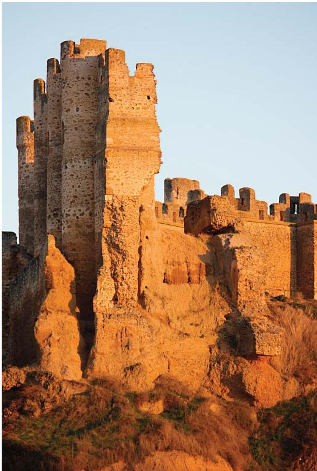
*Detalle del estado del muro de cal y canto y de la ladera que lo contiene. A. Balado, 2010.*
