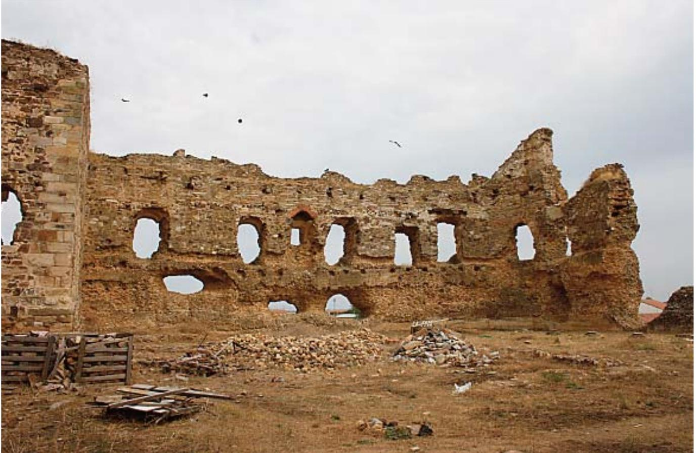
*Tapias de hormigón encofrado y solapamiento de sillería posterior en el interior del castillo. A. Balado, 2010.*
