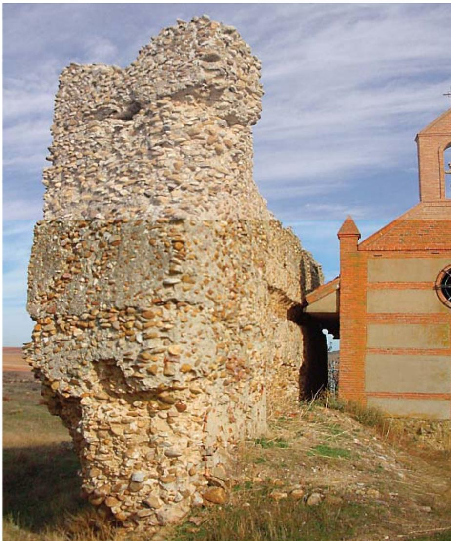
*Restos muro norte y posible torreón. Erosión en la base que está provocando el vuelco. C. Belloso.*
