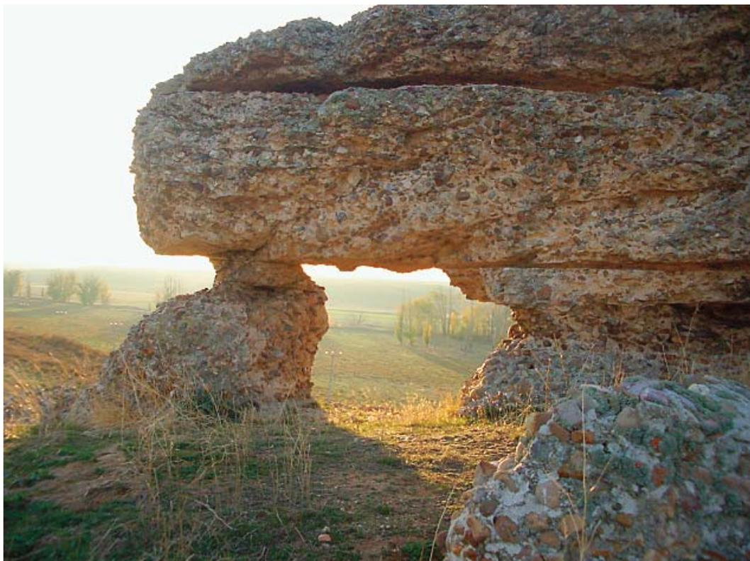
*Detalle de las tongadas de construcción. C. Belloso, 2010.*
