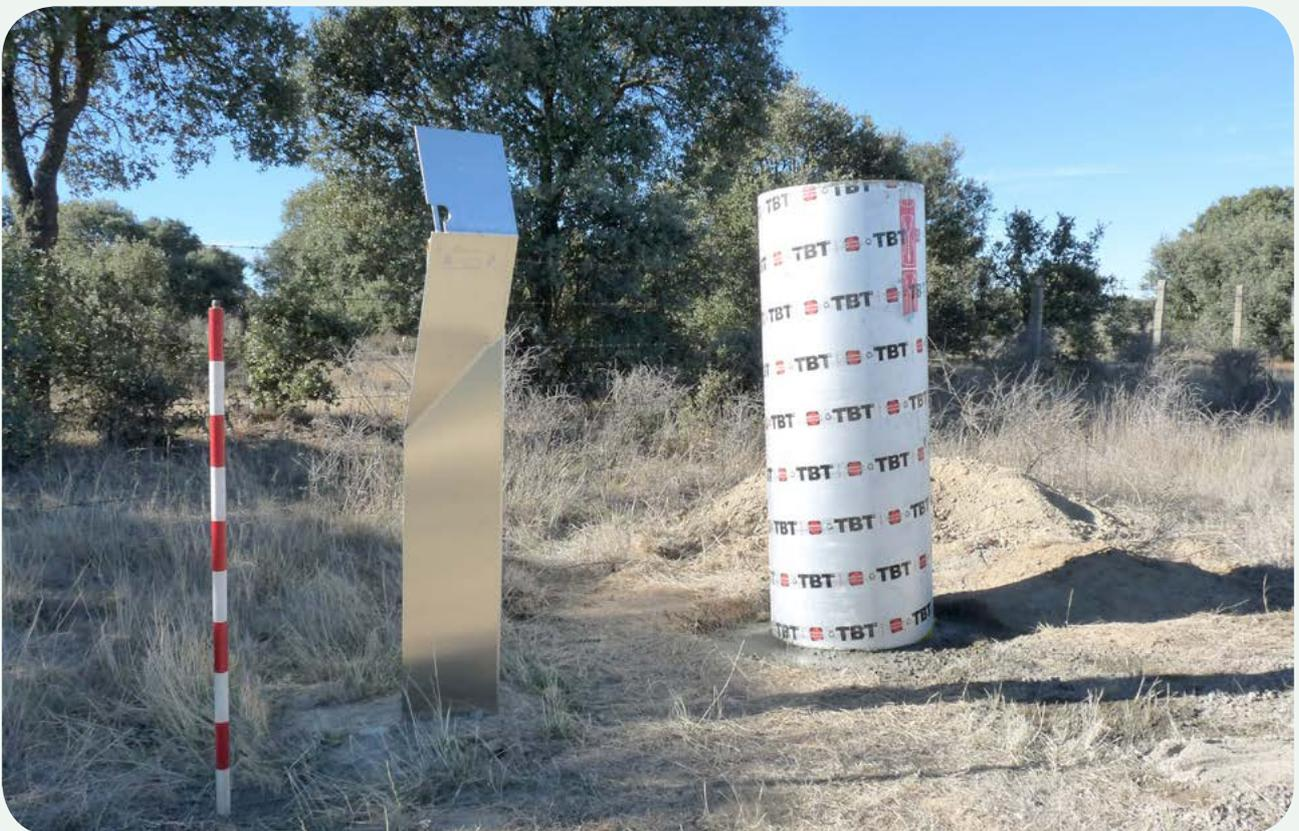
**TRASLADO E INSTALACIÓN EN LA CALZADA (2).** Molde para el cilindro de hormigón, en proceso de fraguado.
