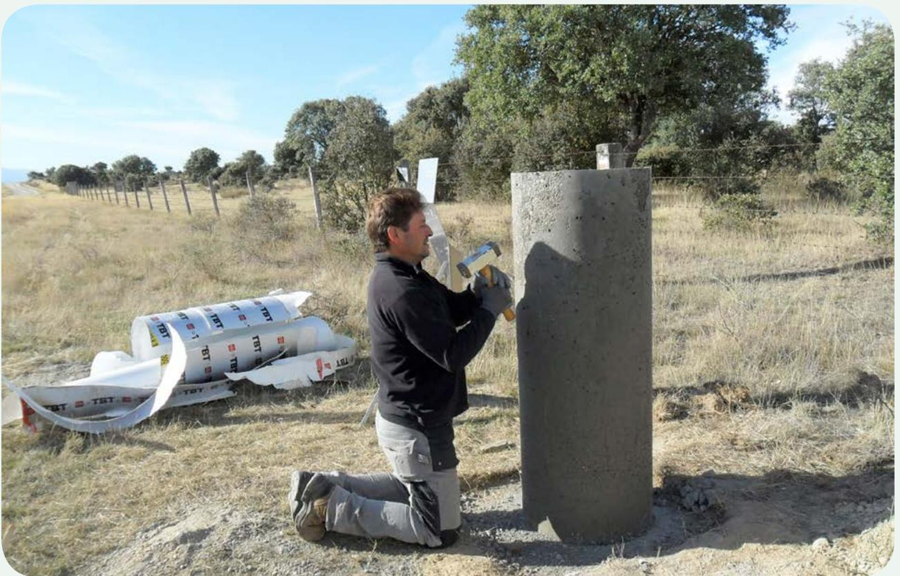
**TRASLADO E INSTALACIÓN EN LA CALZADA (4).** Abujardando manualmente el cilindro, una vez que ha fraguado.
