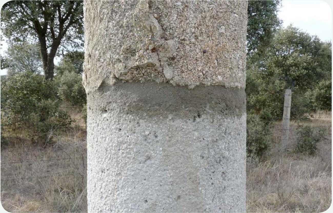
**EL MILIARIO EN LA CALZADA (4).** Zona de unión entre el granito de la columna y el hormigón armado, abujardado manualmente.
