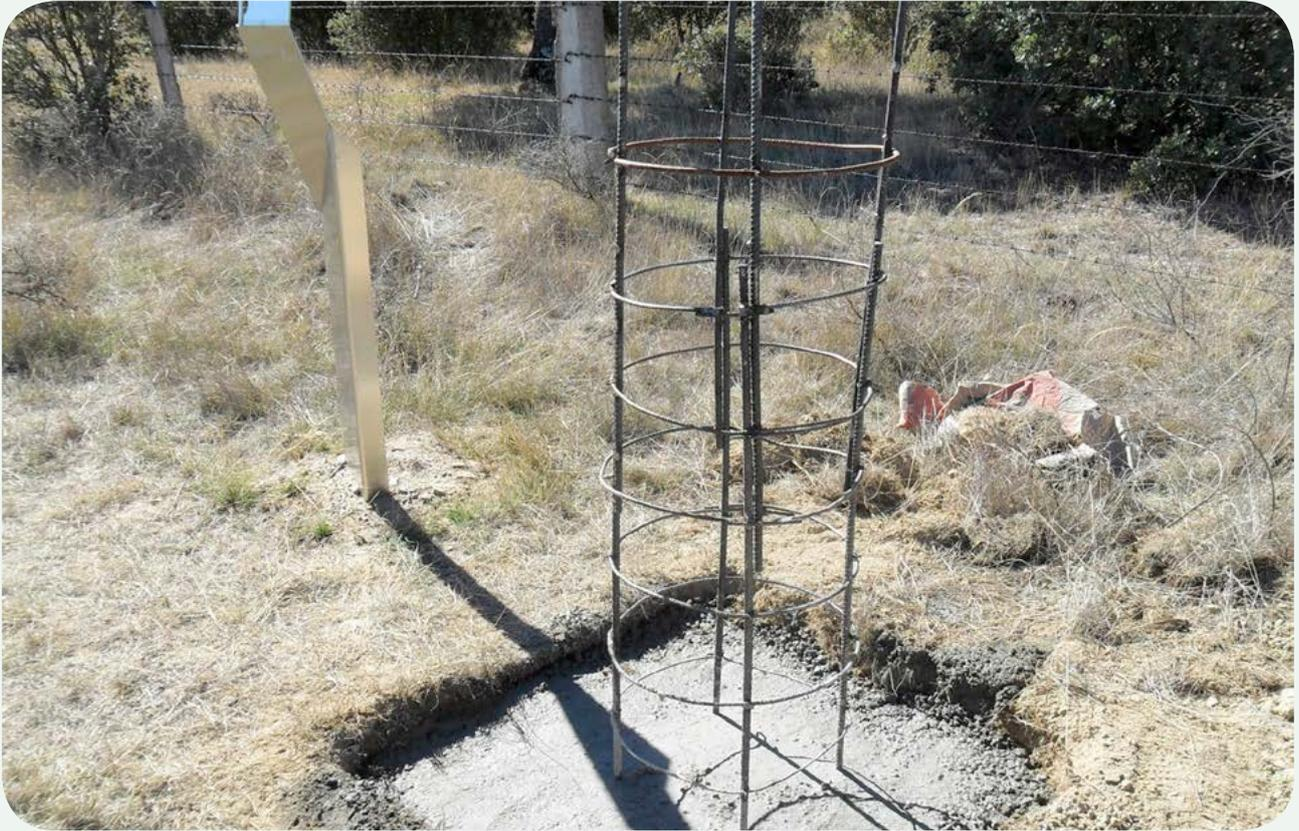
**TRASLADO E INSTALACIÓN EN LA CALZADA (1).** Estructura de hierro para el interior del cilindro de hormigón armado.
