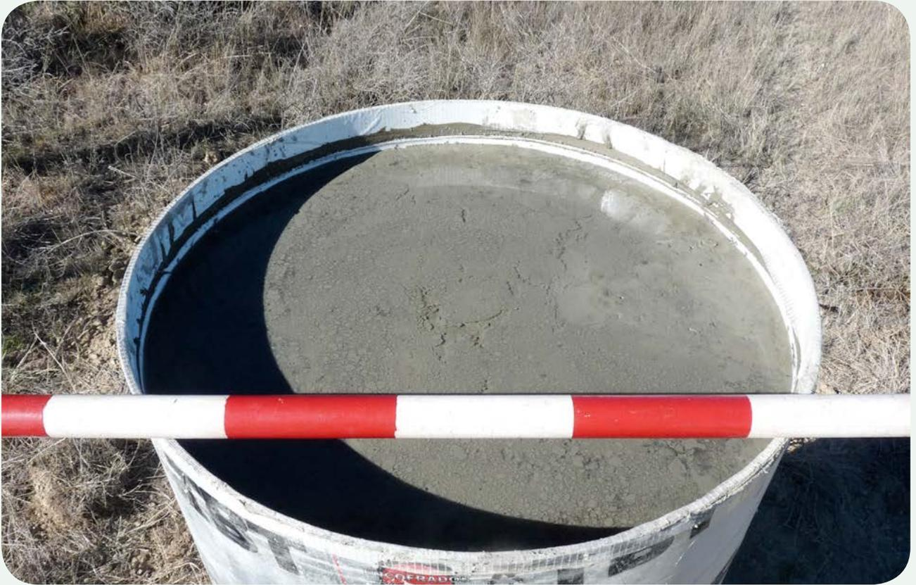
**TRASLADO E INSTALACIÓN EN LA CALZADA (3).** Vista superior del molde, recién vertido el hormigón armado.
