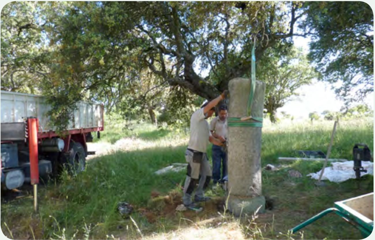
**RECUPERACIÓN, TRASLADO E INSTALACIÓN EN LA CALZADA (6).** Aplomando la columna, a punto de finalizar su instalación.
