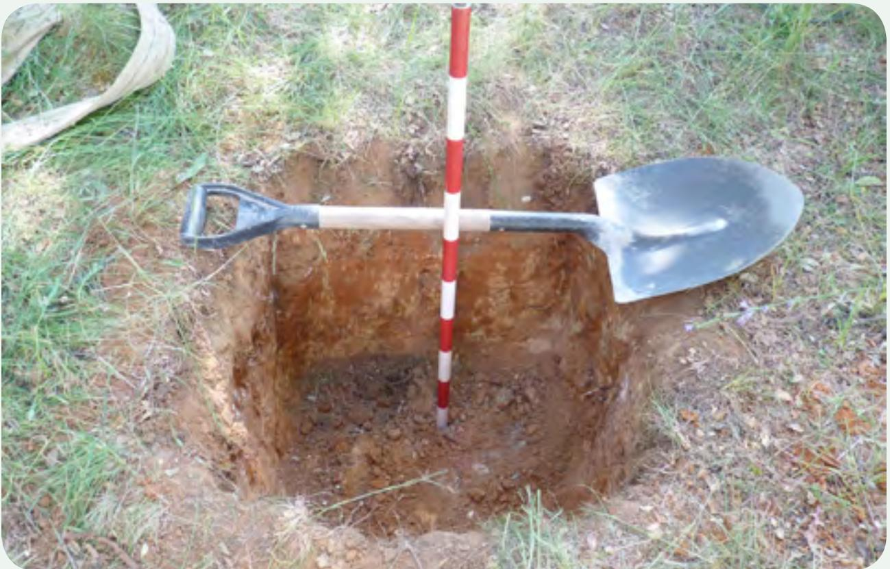
**RECUPERACIÓN, TRASLADO E INSTALACIÓN EN LA CALZADA (3).** Agujero practicado previamente en el terreno a la altura de la milla 165, en la que se alojaría el miliario, sobre una base de cemento.
