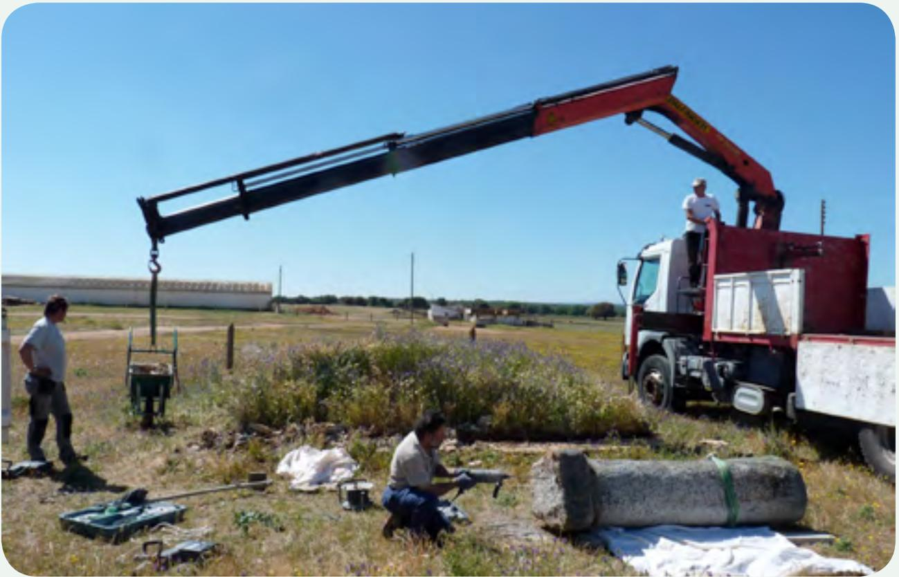
**RECUPERACIÓN, TRASLADO E INSTALACIÓN EN LA CALZADA (2).** Preparando la columna miliaria para su nueva instalación en la calzada romana y desmontando el cercado de alambre y ladrillo donde se encontraba instalada, para su retirada a escombrera.
