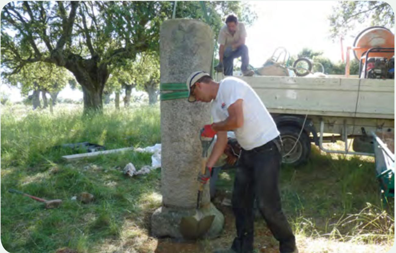
**RECUPERACIÓN, TRASLADO E INSTALACIÓN EN LA CALZADA (5).** Preparando la base de cemento sobre la que asentará la columna.
