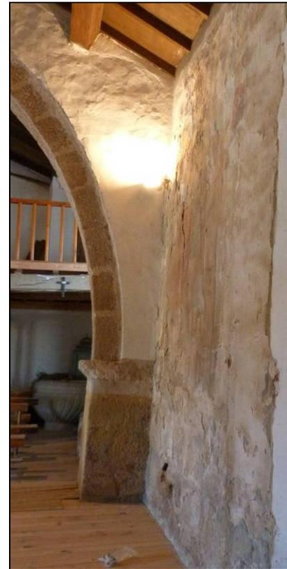
**Fig. 21** - Encalados que aún tapan la pintura, escorrentías y suciedad. **Fig. 22** - Iluminación inadecuada que presentan las pinturas.
