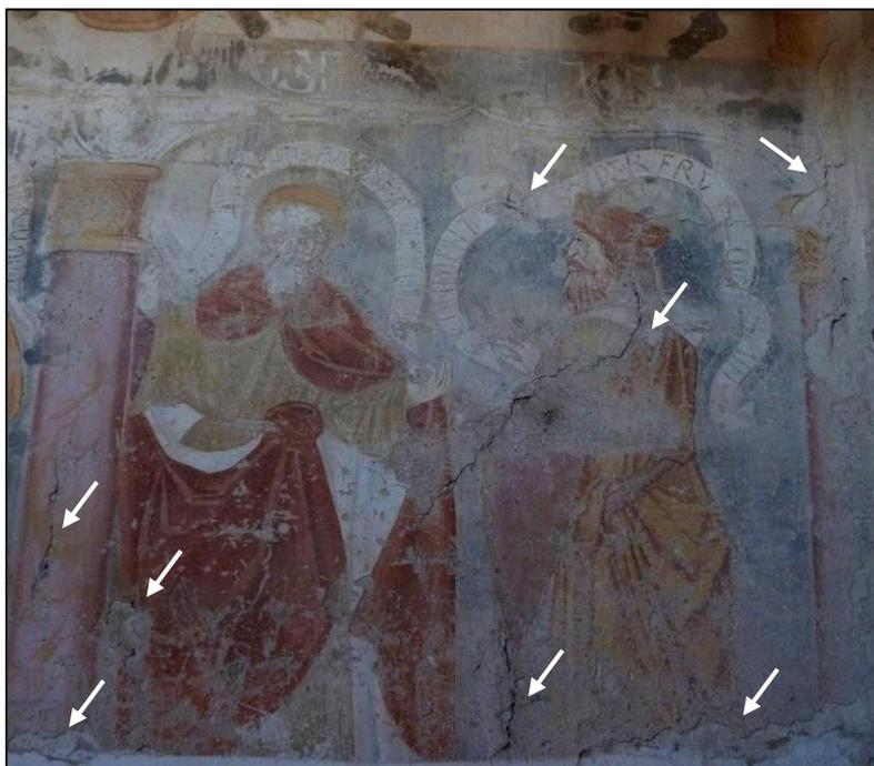
**Fig. 36** - Una escena del Muro Sur. Se han señalado las principales grietas que presenta. Además, se pueden observar escorrentías, sales y pérdidas de policromía por golpes.
