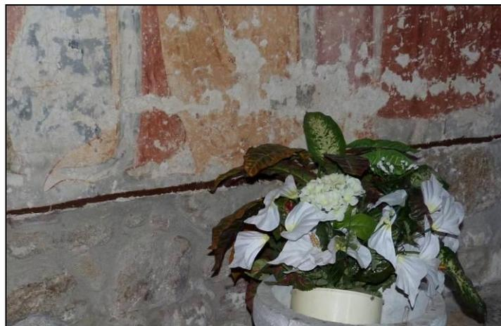
**Fig. 38** - Muro Norte: detalle de las pérdidas de policromía debido a grafitis y golpes.
