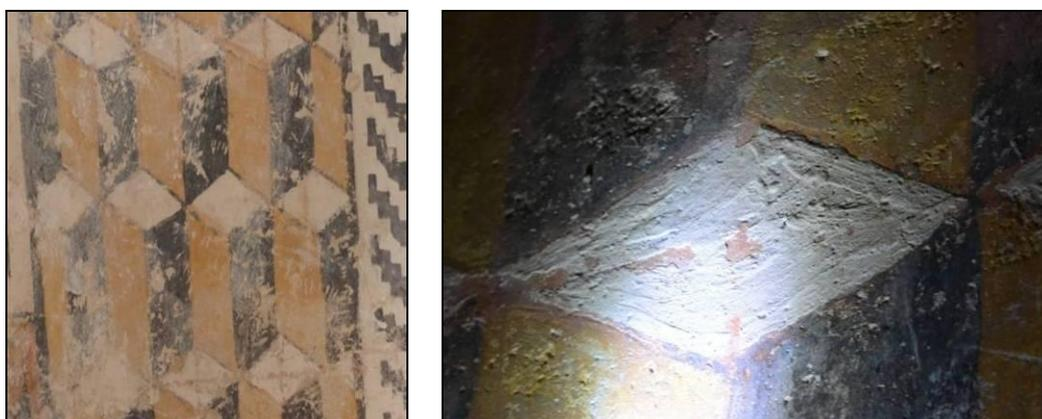
**Fig. 22** - Izquierda: decoración geométrica donde se ven las líneas rojizas, en fresco, que plantean el dibujo, visibles por haberse desprendido la policromía. Derecha: detalle con luz rasante, donde se ve el grosor de la pintura en seco y el fondo rojizo inferior.
