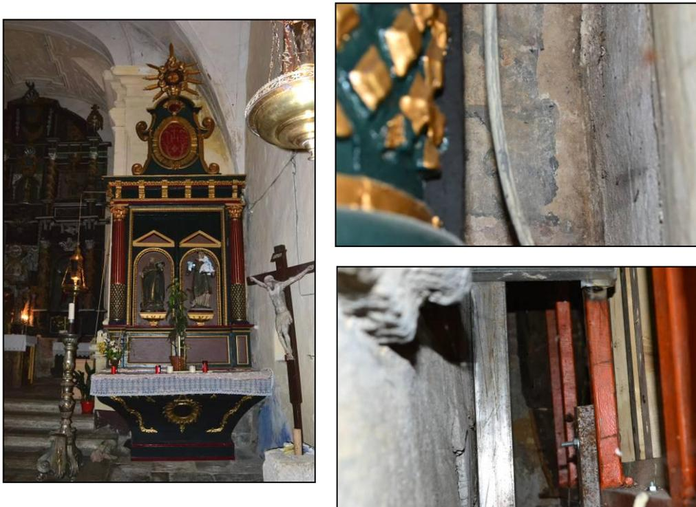
**Fig. 6** - Imagen actual del muro y retablo tras el que se localizan las pinturas. A la derecha, imagen que constata su existencia, visto en el estrecho margen entre la mazonería y el muro. Debajo, nueva estructura metálica portante que sustenta el retablo.
