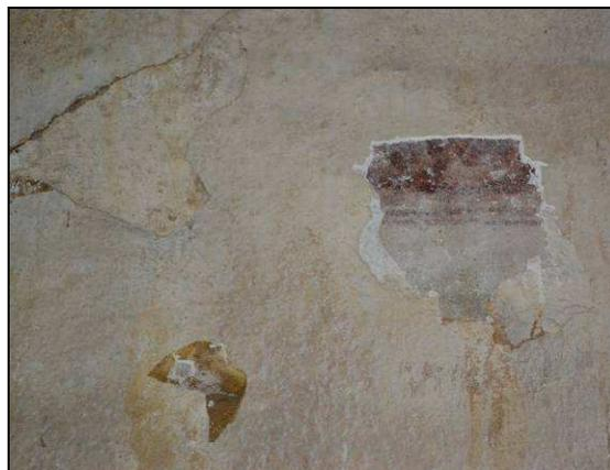
Fig. 26 - Detalle de varias zonas donde se aprecia el grosor de los encalados.
