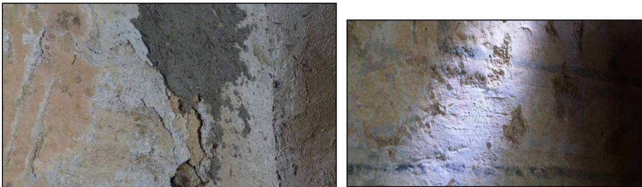
**Fig. 10** - Detalle del estado de las capas superpuestas: parchado de cemento gris y blanco, encalado de cal y arena, sustrato pictórico y mampuesto visible. A la derecha, se ve la irregularidad de la superficie, además de picados y roces.
