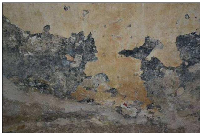
Fig. 25 - Detalle de la zona inferior derecha: superposición de encalados, disgregación y bordeados con cemento para evitar desprendimientos
