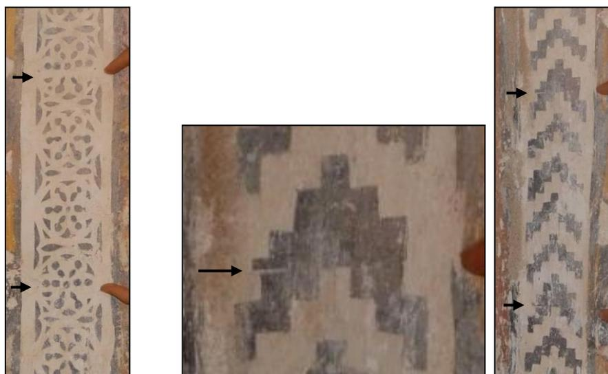
Fig. 25 - Detalles de las dos cenefas en los que se aprecia la plantilla utilizada. A la izquierda: por llevar una inclinación ligeramente oblicua y estar la siguiente plantilla, en la parte superior un poco más separada, deformando la *flor*. A la derecha: se ve un fallo en la colocación de la plantilla, haciendo el motivo decorativo en espiga más grueso, además de verse un corte horizontal, de los extremos superior e inferior de la plantilla.
