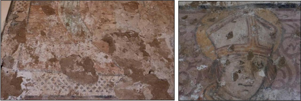
**Fig. 19** - Pérdidas de mortero, cuyas capas están separadas y acumulación de barro, tanto en las lagunas como en las picadas y superficie en general. Derecha: detalle de las picadas con barro acumulado.
