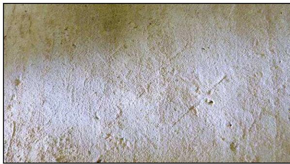
**Fig. 27** - Impronta de la plantilla en el mortero, visto con luz rasante.
