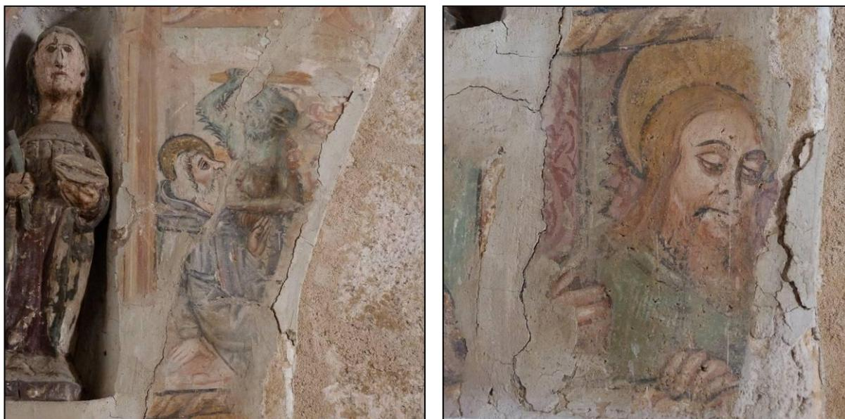
**Fig. 35** - Grietas del mortero, algunas concentradas alrededor de la hornacina, apliques de cemento y otros morteros y mal estado de conservación de los bordes de la pintura.
