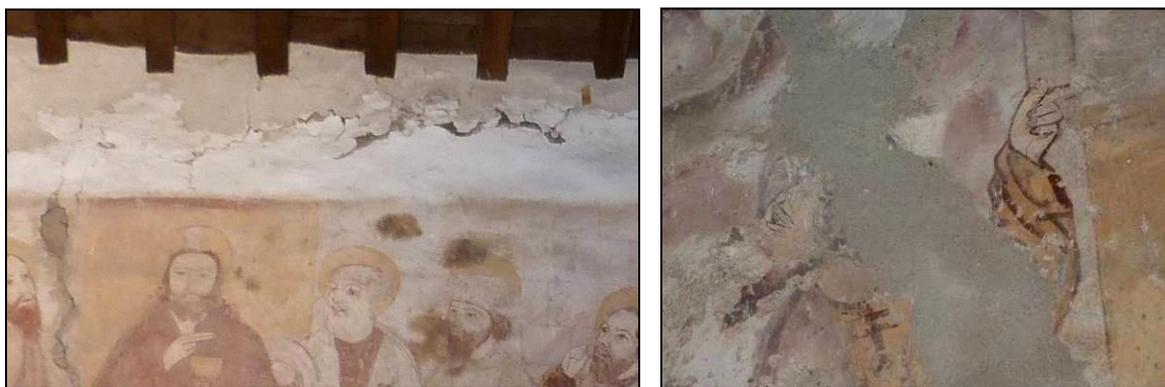
Fig. 58 - Grietas, algunas con cemento, manchas de humedad y desprendimientos, en el muro D1.
