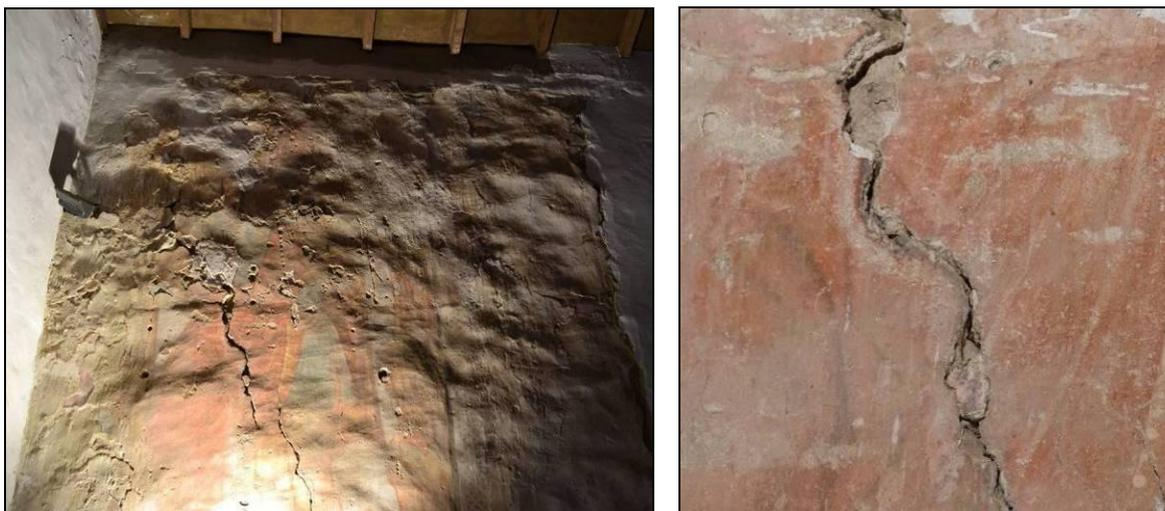
Fig. 19 - Irregularidades del muro, visto con luz rasante. Derecha: detalle de la zona central de San Cristóbal: gran grieta y separación de las capas de mortero.
