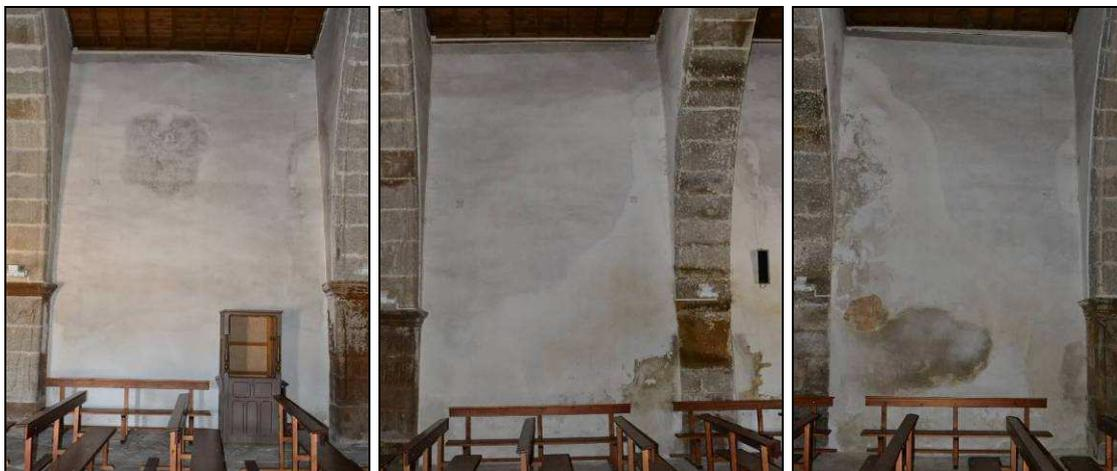
Fig. 33 - Humedades en el lado Norte: segundo y cuarto tramo de la nave. Derecha: lado Sur: cuarto tramo de la nave.
