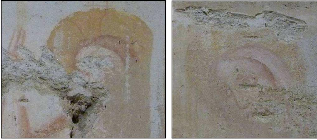
**Fig. 25** - Diferencia de saturación del color entre dos de los nimbos, debido a una mayor terminación del primero y a una pérdida parcial de policromía en el segundo caso, probablemente de la aplicada en seco.
