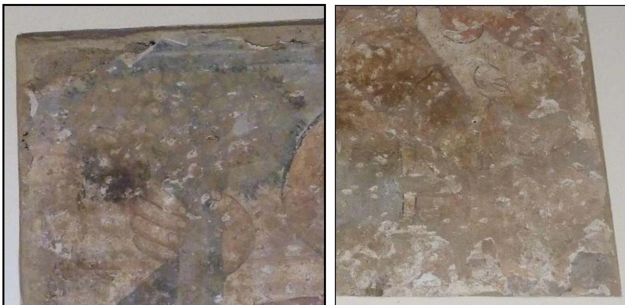
Fig. 25 - Detalles de las pérdidas de mortero en todo perímetro, y picadas, sales, restos de encalados y suciedad generalizada.
