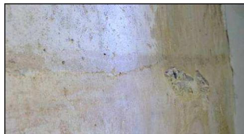
**Fig. 28** - Esquema con las jornadas de trabajo y detalles con luz rasante de la superposición de las mismas.
