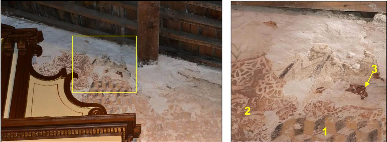
Fig. 17 - Detalle de la parte superior del testero donde se aprecian restos de dos capas de pintura: decoración de colgaduras realizada a plantilla (capa 2) y fragmentos de color (capa 3). Ambas posteriores a la capa principal (capa 1).
