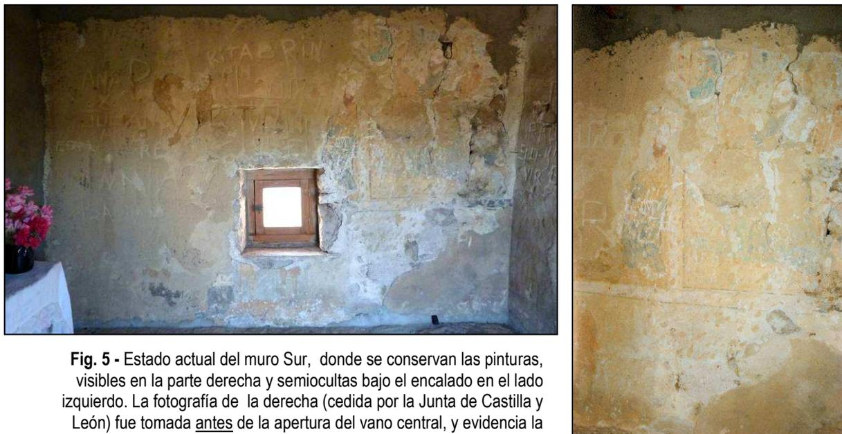
**Fig. 5** - Estado actual del muro Sur, donde se conservan las pinturas, visibles en la parte derecha y semiocultas bajo el encalado en el lado izquierdo. La fotografía de la derecha (cedida por la Junta de Castilla y León) fue tomada antes de la apertura del vano central, y evidencia la destrucción de las pinturas de esa zona.
