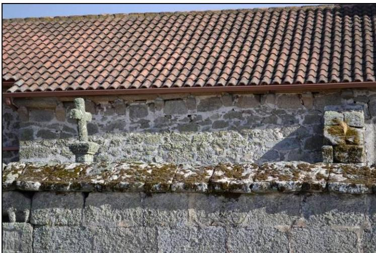
Fig.18 - Exterior del muro B, que no parece presentar problemas estructurales. En primer plano: muro del cementerio
