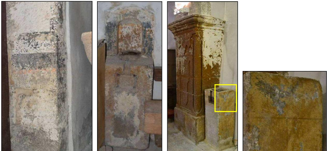
**Fig. 37** - De izquierda a derecha: restos de capas de pintura junto a la puerta de acceso; bajo el coro; y en el primer arco de la nave, lado Norte, con un detalle de la decoración imitando un despiece de sillería.
