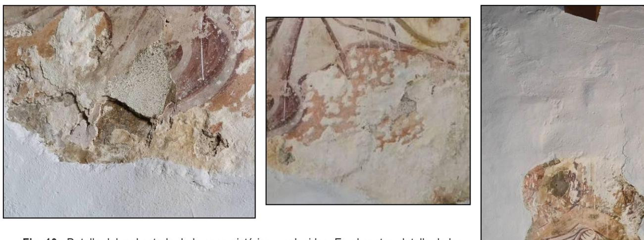
Fig. 10 - Detalle del mal estado de la capa pictórica y enlucidos. En el centro, detalle de los picados, algunos relleno de cal. A la derecha, detalle de zona oculta por el enlucado.
