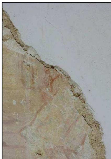
**Fig. 30** - Detalle del grosor de un mortero superpuesto.
