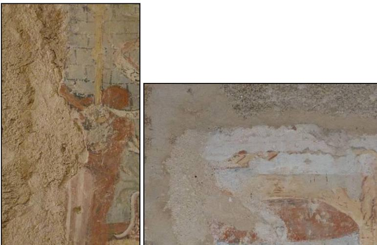
Fig. 35 - Detalle del cemento que bordea las pinturas y detalle de la parte superior donde se puede ver que existen dos capas de mortero.
