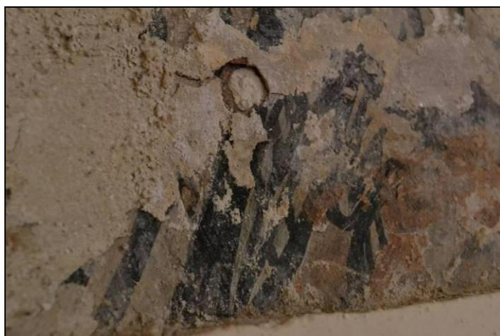
**Fig. 30** - Detalle de la parte inferior izquierda: costras de sales y cemento, y suciedad superficial.
