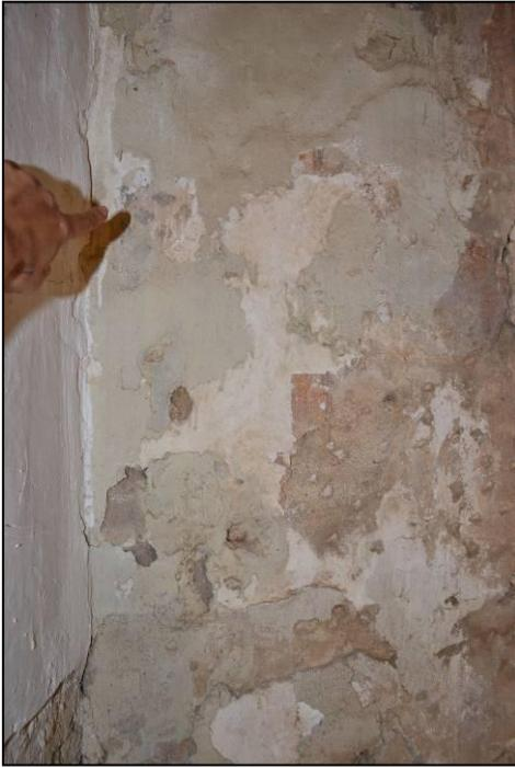
**Fig. 20** - Izquierda: parte inferior de las pinturas: abundantes encalados superpuestos y cemento. Abajo: cemento aplicado en las rozas y caja del cableado.
