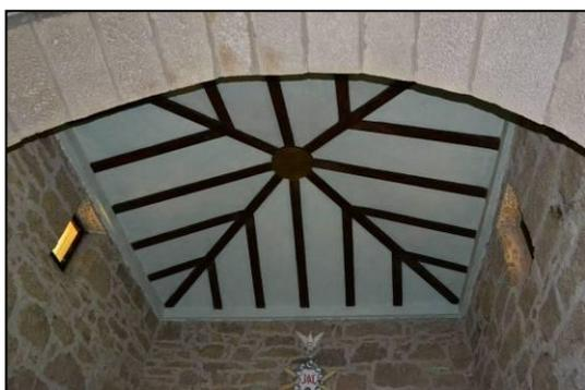
Fig. 4 - Nueva cubierta de la cabecera, a cuatro aguas en el exterior.
