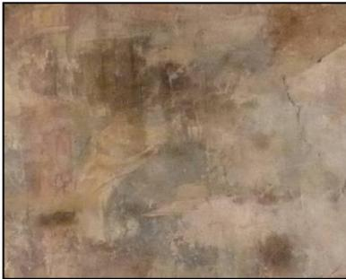
**Fig. 59** - Escorrientías en el muro E. Abajo: manchas de humedad en la parte superior central del muro D2, en el que prácticamente no se reconoce nada por las pérdidas de policromía.
