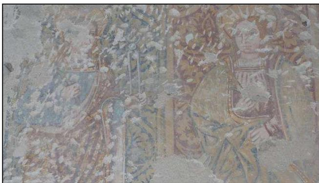
Fig. 34 - Izquierda: muro A, escena inferior: pérdida de mortero por roces y golpes. Derecha: muro B, picado para recibir encalado.
