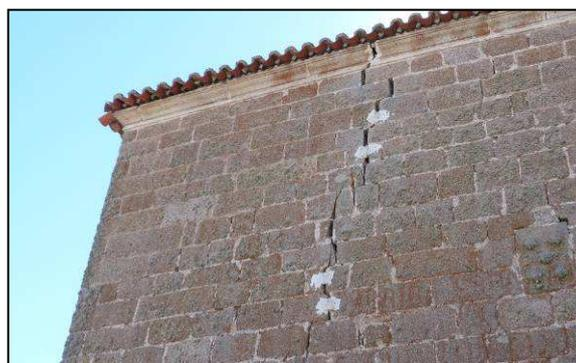
Fig. 9 - Testigos de control en una grieta de la cabecera.
